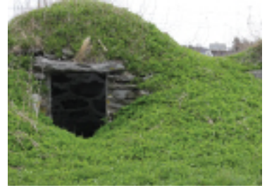
Foto: Bygg og bevar
